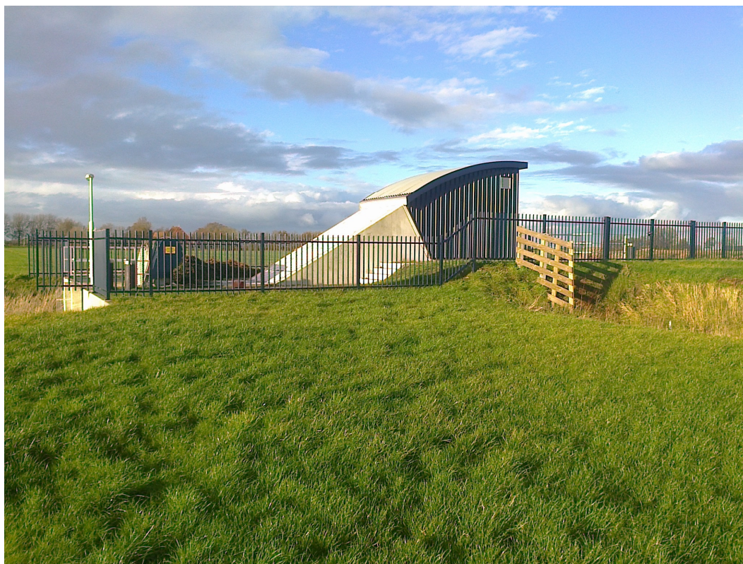
Het nieuwe gemaal van de Rijsterpolder.
